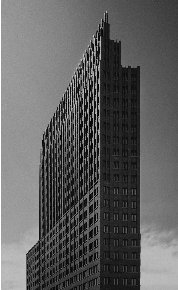
Abb. 96: Exakt korrigierte stürzende Linien erzeugen eine klare, aber streng anmutende Bildwirkung dieses Hochhauses.
