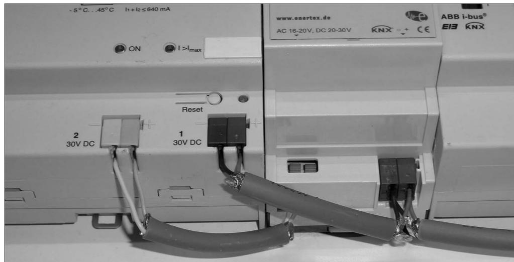
Abbildung 6.10 Aufstecken der Busklemmen auf die KNX-Geräte
