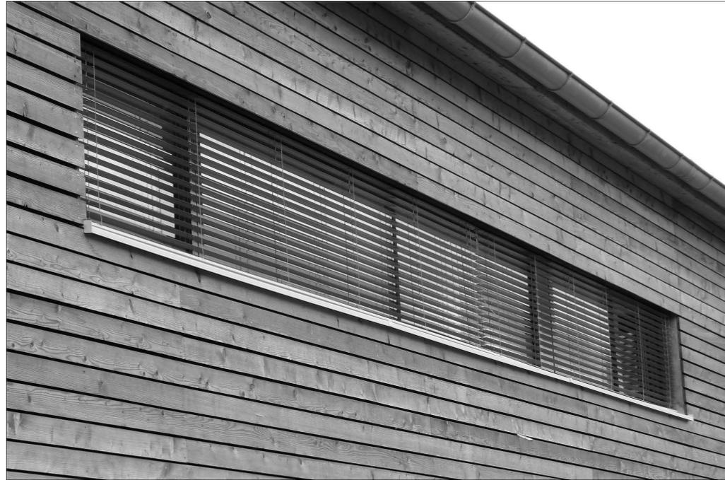
Abbildung 3.2 Außenjalousien, in die Gebäudesteuerung integriert
