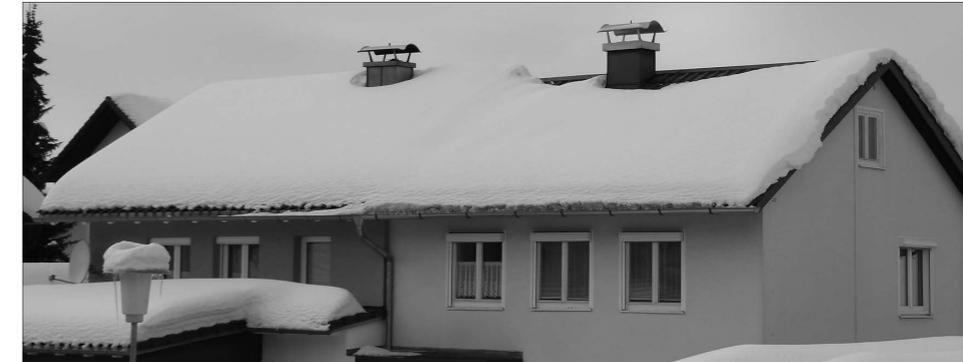
Abbildung 2.1 Doppelhaushälften mit weniger Dämmung (rechts) und mit mehr Dämmung (links)
