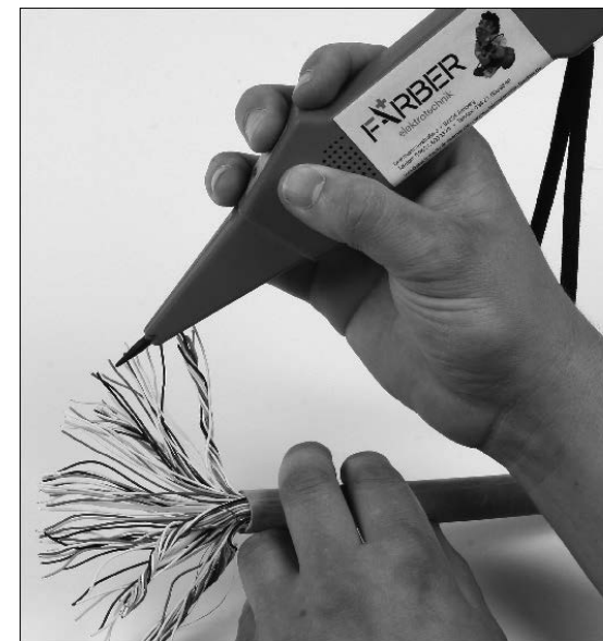
Abbildung 2.30 Arbeiten mit dem Tastkopf an einem Adernbündel
