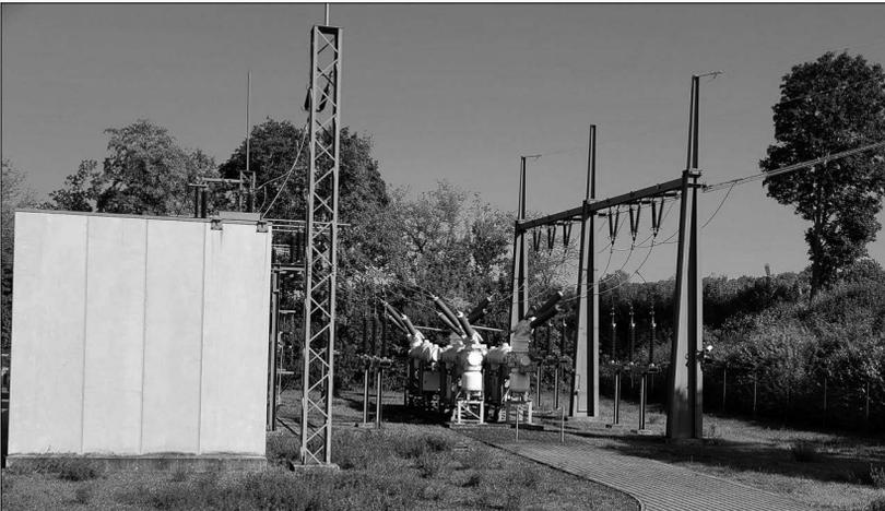
Abbildung 2.8 Ansicht eines Umspannwerkes vom Hochspannungsnetz zum Mittelspannungsnetz
